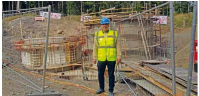
Besichtigung der Trinkwasserversorgungsanlage Gmeineck im Zuge der wöchentlichen Baubesprechung
